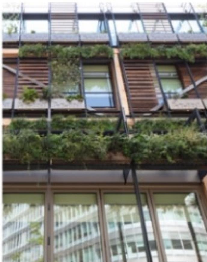
Pour le vitrage, on a choisi le **COOL-LITE SKN 176 II**, un verre à contrôle solaire hautement transparent et de couleur neutre, qui permet des effets de lumière particulièrement naturels tant à l'intérieur qu'à l'extérieur.
