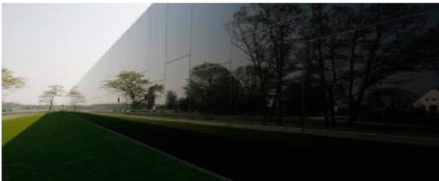
ADBC centre et son hall de 500 m<sup>2</sup> est une structure simple, c'est en principe l'idée d'une boîte dans une boîte. La boîte extérieure est une structure en verre et acier et la partie intérieure est fabriqué sur base de béton préfabriqué. Pendant la journée, le bâtiment est perçu comme un bloc homogène noir, où même les portes sont invisibles. La façade en verre a été construite sur base d'un système VARIO et du verre [PARSOL](#) gris, qui donne une élégance simple au bâtiment.
