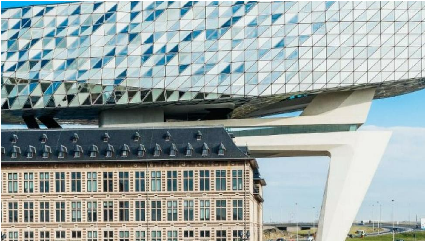
Maison du port d'Anvers façade Saint-Gobain
